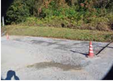
①施工現場
