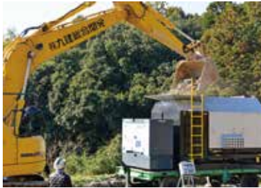
④剥ぎ取った舗装をユニットに入れる
