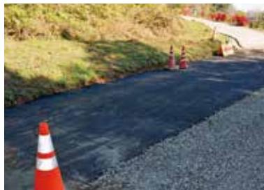
⑪現場完成
