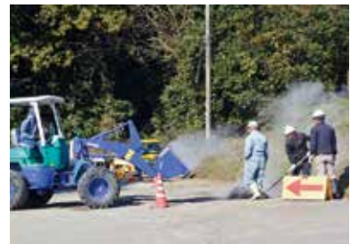
⑨現場への流し込み
