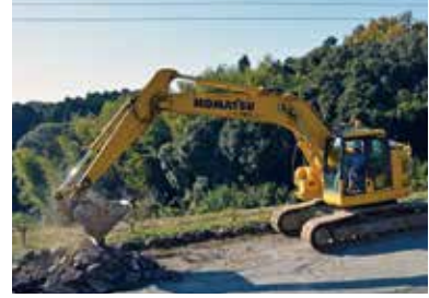
③舗装の剥ぎ取り開始
